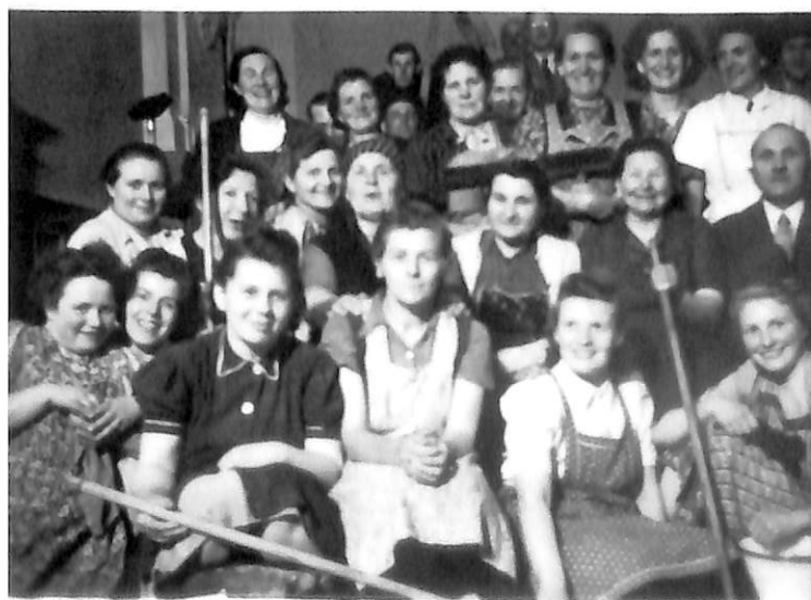
Bild 19 Reinigung der Staatsbauschule
