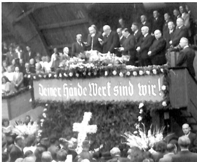
Bild 22 Blick auf den Altar in der Auktionshalle
